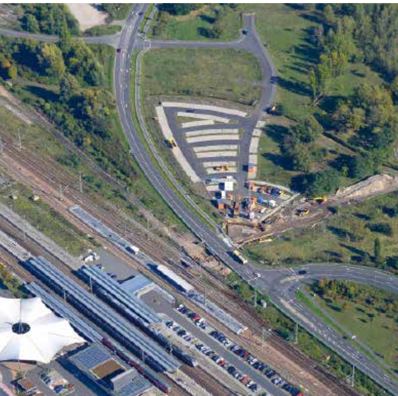
Ankunftsraum Hauptbahnhof und Bahnhofsstseite
